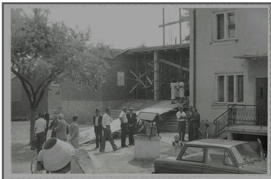
Dom mieszkalny państwa Prugarów, a w tle budowa kościoła
